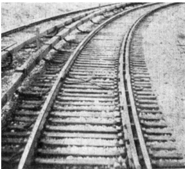
Рис. 19. Путь с охранным контррельсом
