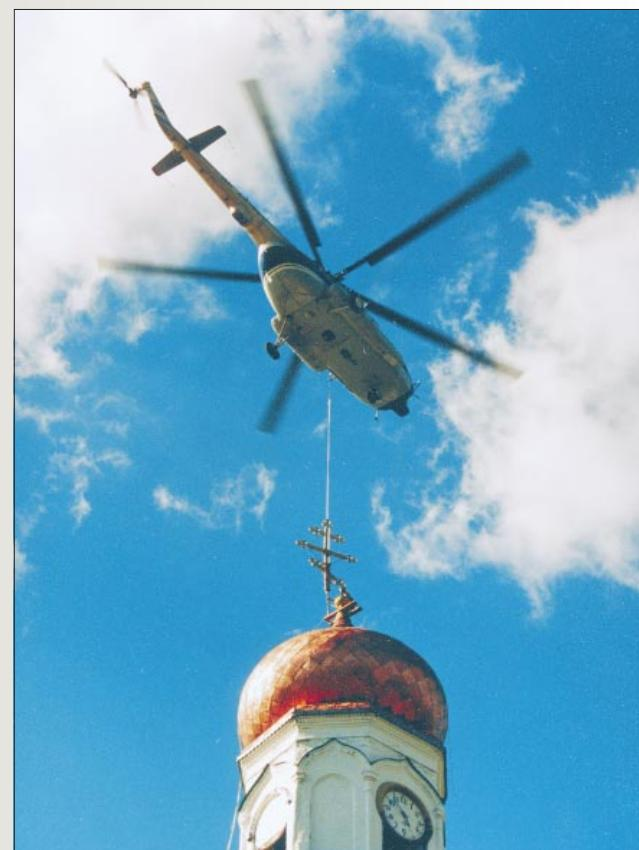
**Ми-8МТВ привлекается для проведения высокоточного монтажа конструкций**
