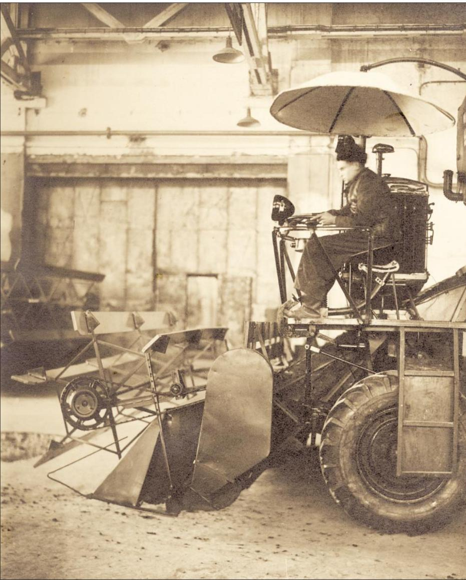
**Комбайн С-4 с новой удлиненной площадкой, позволяющей улучшить обзор из кабины и облегчить труд комбайнера. В уборочной кампании 1949 г. госкомиссия присуждает казанскому комбайну 1 место за высокую эксплуатационную надежность**
