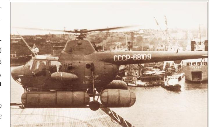
**Ми-1Г с поплавковым шасси. Посадка на палубу корабля**
