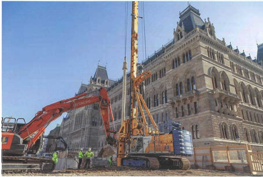
Строительные работы в центре Вены по устройству пересадочного узла Ратхаус
