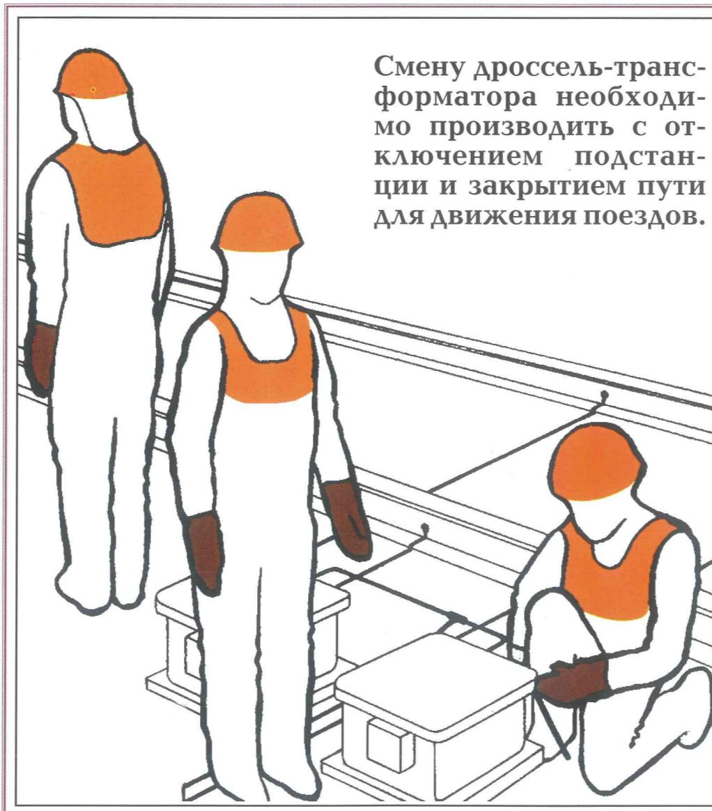
Смену дроссель-трансформатора необходимо производить с отключением подстанции и закрытием пути для движения поездов.
